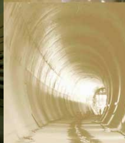
Móricz Zsigmond körtér M4 METRÓ állomási műtárgy Móricz Zsigmond square M4 Station structure (under construction), Budapest
